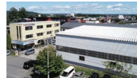
タチノウェストビル&貸倉庫
