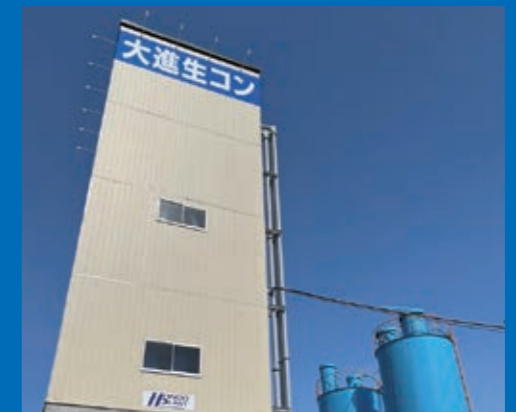
大進生コン 鹿追工場 鹿追町北町1丁目10
